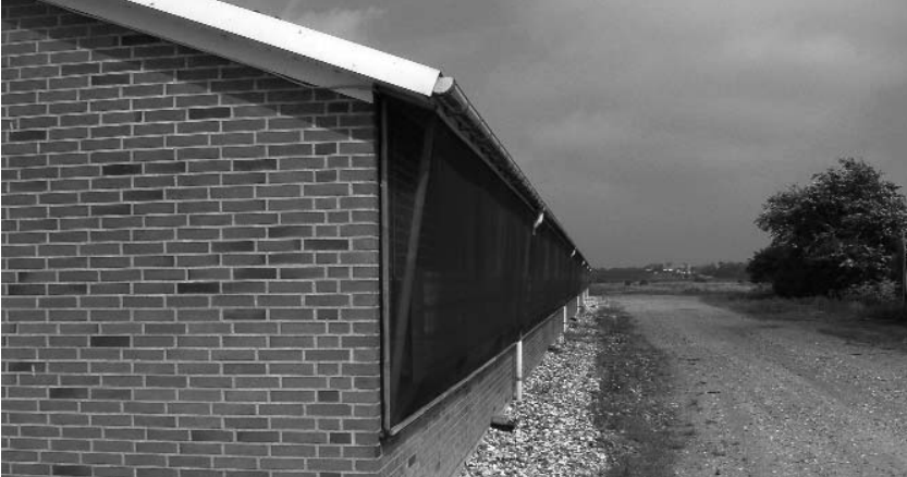
Figur 2.1. Kyllingehus, der er sikret med insektværn. Billedet viser fluenet monteret på luftindtagsventilerne på siden af huset. Derudover var der sat net på døre og andre åbninger til det fri. Foto: Birthe Hald
